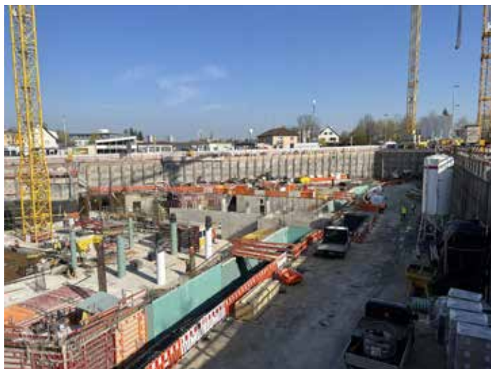
Blick in die Baugrube 2
