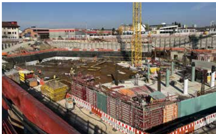
Blick in die Baugrube
